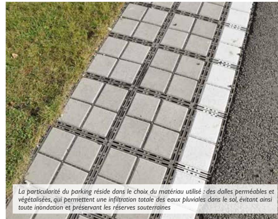
La particularité du parking réside dans le choix du matériau utilisé : des dalles perméables et végétalisées, qui permettent une infiltration totale des eaux pluviales dans le sol, évitant ainsi toute inondation et préservant les réserves souterraines
